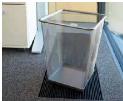
Abb. 2: Zugestellter Luftauslass.
